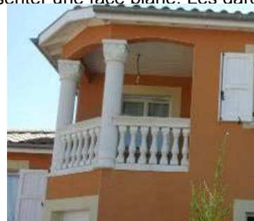
Type de balustres interdites
