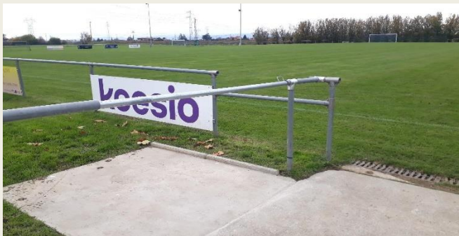
Dalle béton pour PMR à l'arrière de la main courante de terrain de foot
