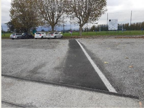
Cheminement extérieur PMR d'accès au stade de foot
