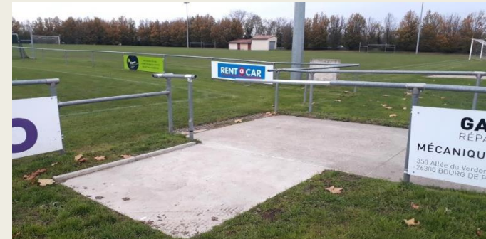
Dalle béton pour PMR à l'arrière de la main courante de terrain de foot
