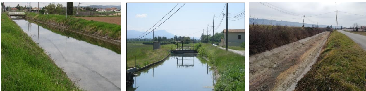
Figure 15 : Le canal de la Bourne à proximité du site et point de récupération des eaux (photos à gauche d'avril 2023, milieu de 2013 et à droite de mars 2023)
